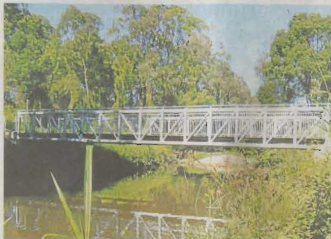
Il ponte a Brisbane in Australia dedicato all'immigrato di Sorgà
